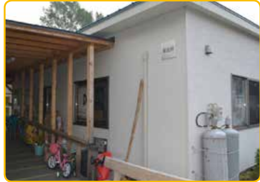
卸町五丁目仮設住宅の集会所
