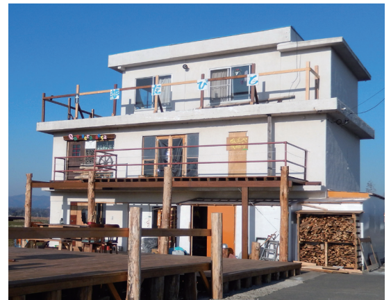
完成したコミュニティスペース「夢たびと BASE」
