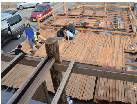
ウッドデッキも手づくり!
