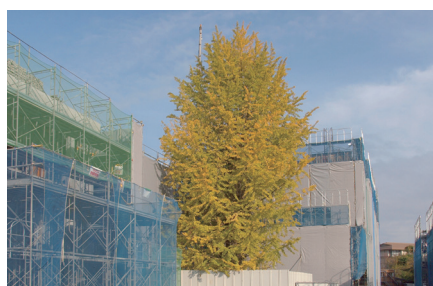
4月以降の入居開始を目指し建設中の霊屋下第二復興公営住宅。中央のイチョウは保存し、周囲を「コミュニティ広場」とする（昨年11月11日撮影）
