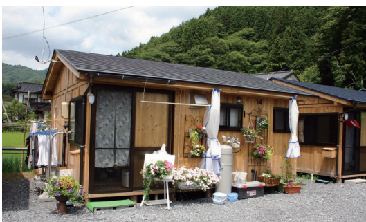
木造戸建ての仮設住宅
