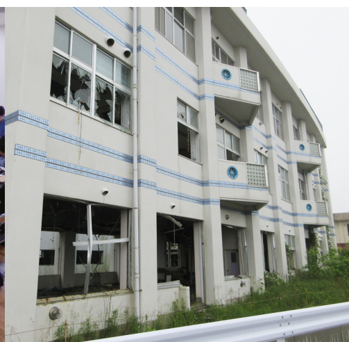
被災した旧宮城県気仙沼向洋高等学校校舎を視察
